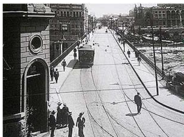
San Paolo, Viaduto do Chá (1916-17)
