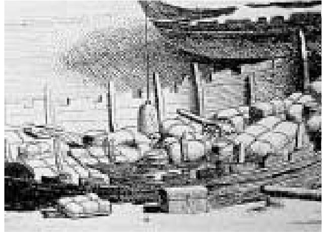
fig.13: Cornelius Meyer (1685). Nella "figura decima" del suo "L'arte di restituire a Roma la tralasciata navigazione del suo tevere" rappresenta questa campana in fase operativa per la posa di una carica di esplosivo all'interno del relitto.
